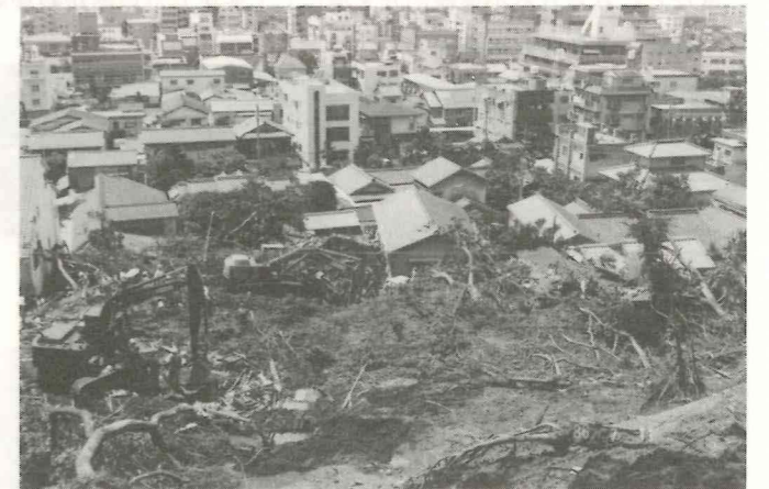
写真-4 シラス斜面の樹木の滑落
