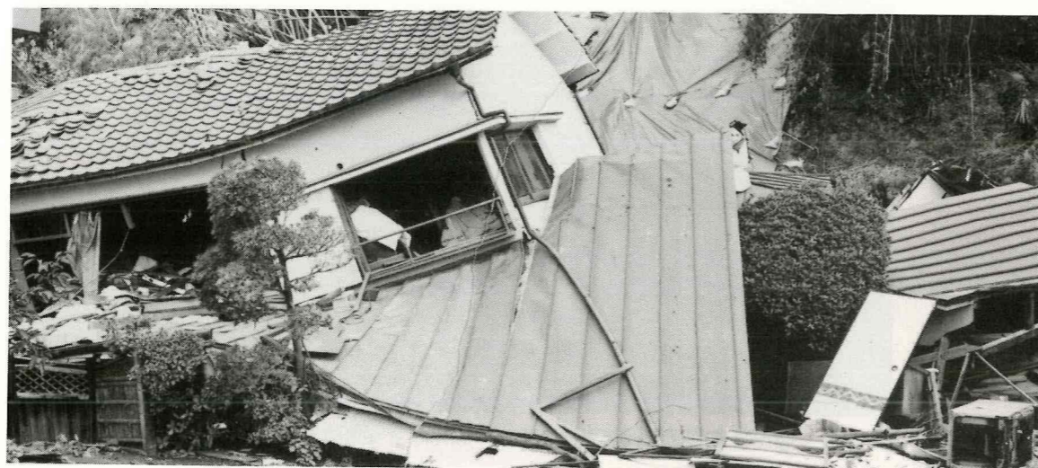
鹿児島市平之町災害現場および家屋被害状況（提供 応用地質株式会社）
