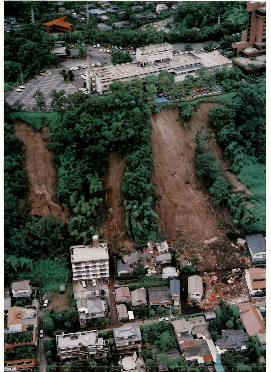
鹿児島市平之町災害現場（提供 国際航空写真株式会社）
