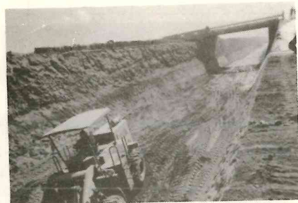
写真-5 野尻川流路工
