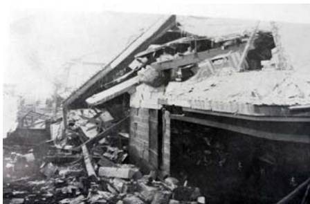
写真 2-11 家屋の地震損害
