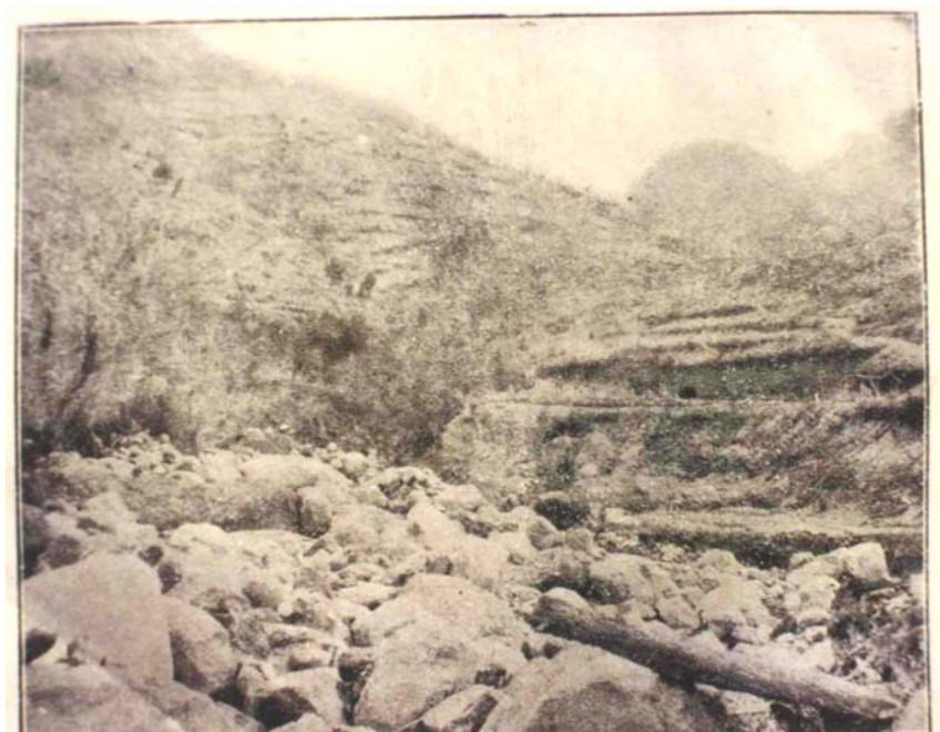
写真 2-17 垂水村川崎川における土石流跡の惨状 出典：肝属郡役所, 1915
