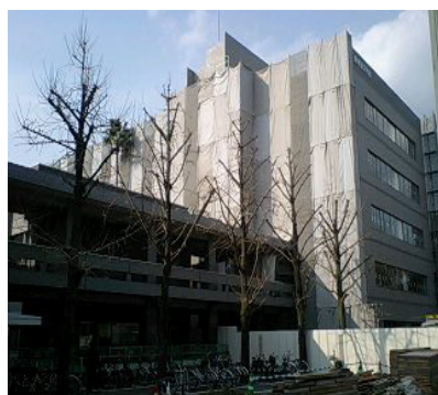
改修中の理学部2号館
